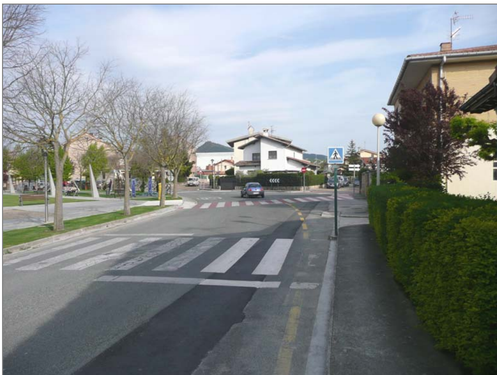
Acera insuficiente y discontinua, con barreras arquitectónicas
