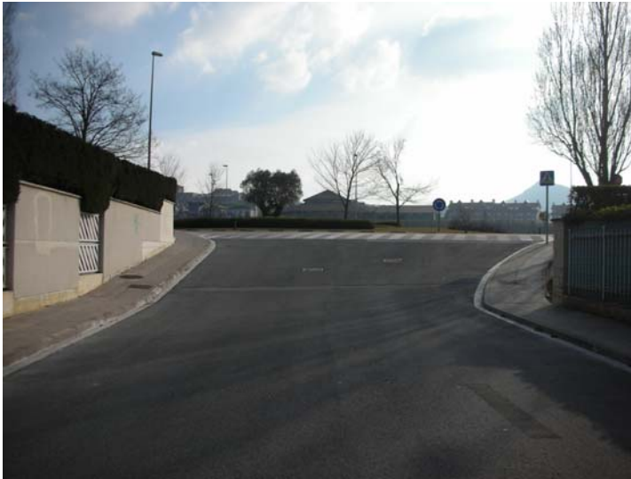
Imagen 2 En la imagen se observa la desproporción existente entre la sección de la calzada y de las aceras.
